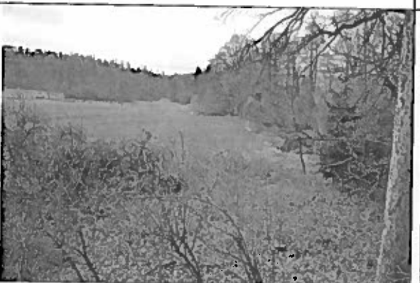
Lokalita vhodná ke stavbě poldru na Tloskovském potoce nad Krusičany v místě porušené hráze původního rybníka – vhodná lokalita ke stavbě dvou jednokomorových poldrů včetně mokřadů v horní části vzdutí.
