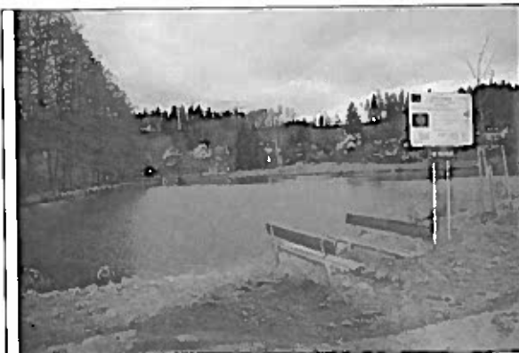
Rybník (Štičí) na Lomnickém potoce v blízkosti dálničního přivaděče v Mirošovicích. Nad tímto rybníkem je lokalita zaniklého rybníka, který by mohl být použit na realizaci poldru nebo přehrážky. Tento rybník je na první pohled v dobrém technickém stavu.
